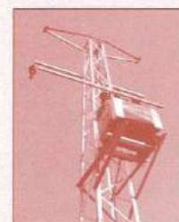
**De intemperie (CTI):** está montado sobre un poste de una Línea aérea de AT. Las protecciones de alta tensión las forman generalmente, fusibles tipo Cut-Out XS, situados en el apoyo inmediatamente anterior. Las protecciones de baja tensión y los equipos de medida se instalan en un armario en el pie del apoyo. Son válidos hasta 160 kVA y se usan mucho en zonas rurales.
