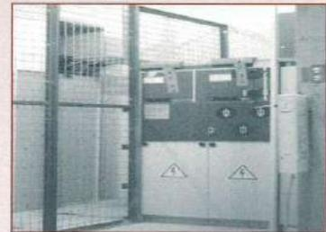
**En edificio:** sus elementos se alojan dentro de un edificio o local destinado a tal efecto.
